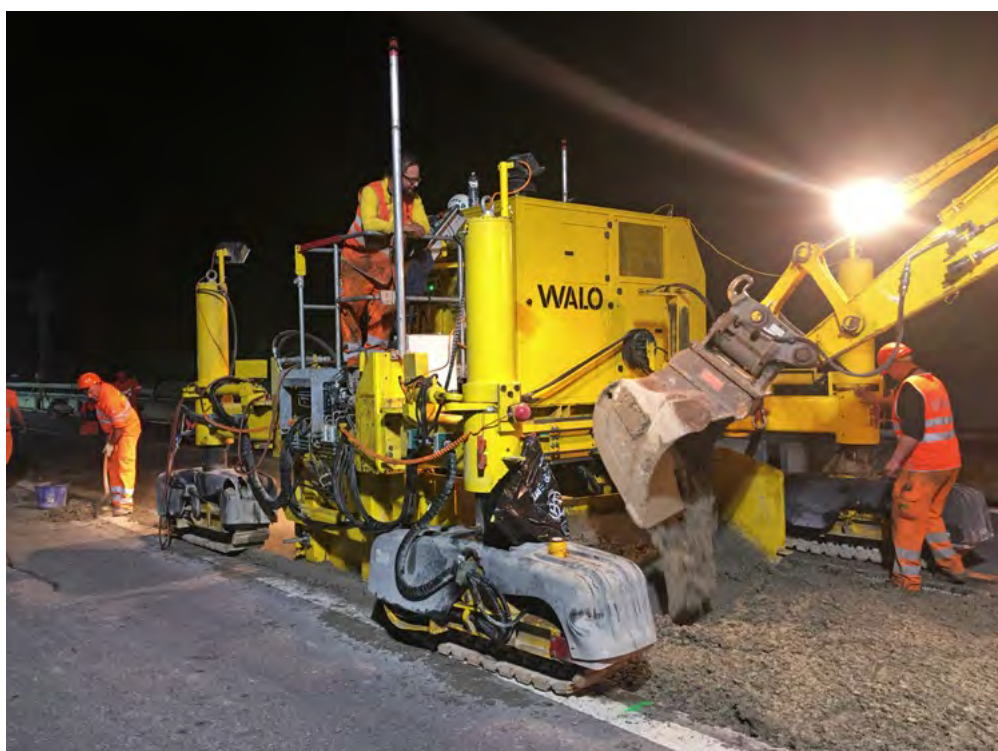
Mise en place mécanique au finisseur à coffrage glissant
