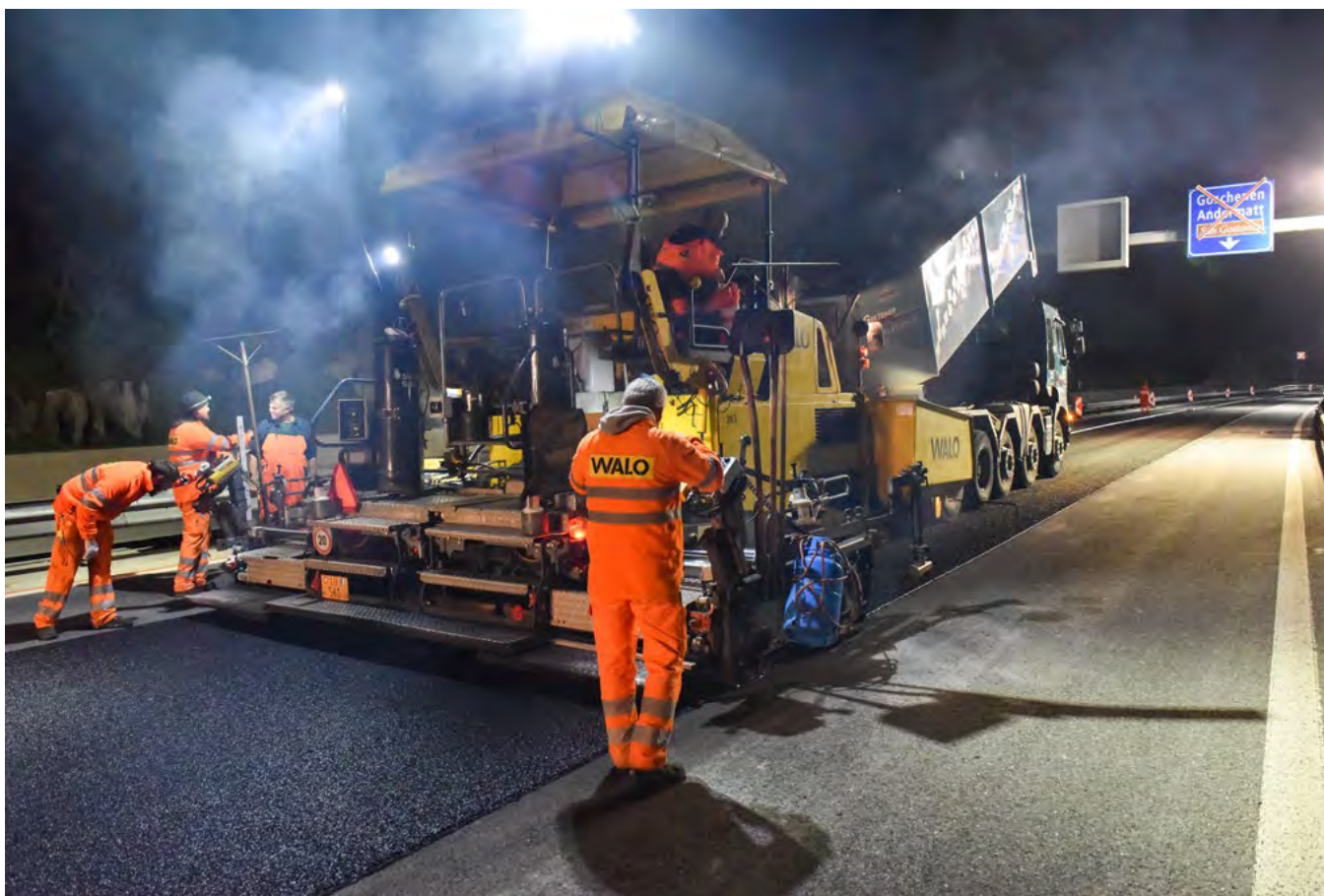
Mise en place du revêtement de surface SDA 8-12
