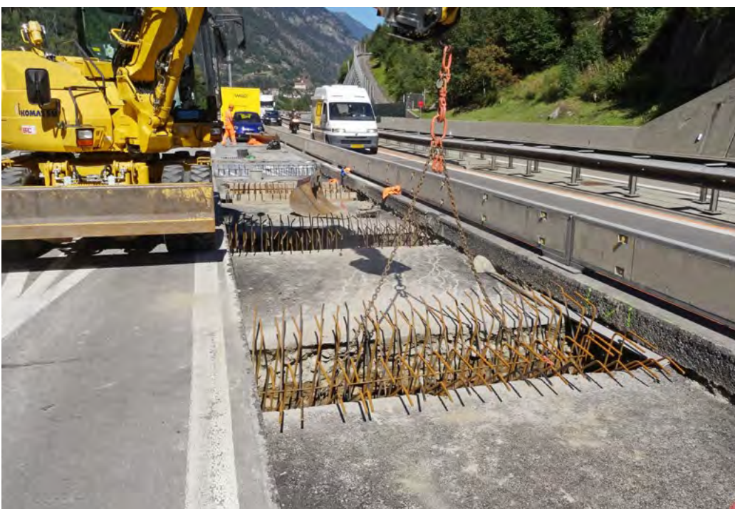
Armature des ancrages terminaux
