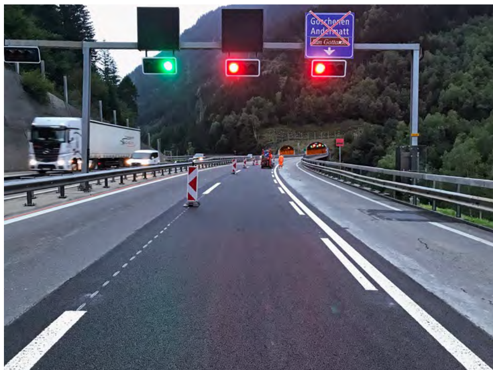
Prête pour l'ouverture au trafic (vue en direction du sud)
