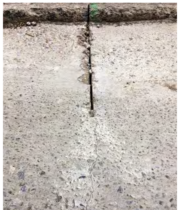
Active Crack Control et répartition homogène des fissures tous les 1,20 m-2,50 m / largeurs des fissures 0,1 mm-0,5 mm
