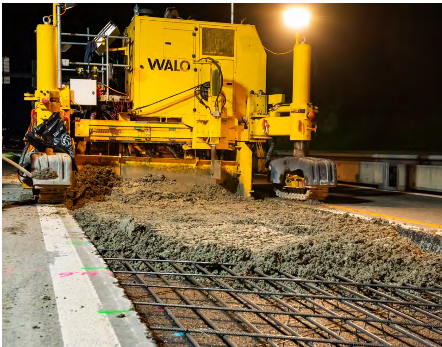
Mise en place mécanique au finisseur à coffrage glissant
