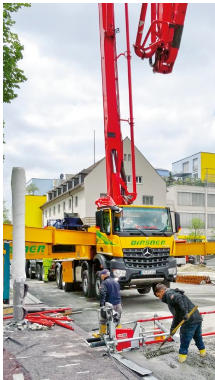
Mise en œuvre du béton à la pompe
