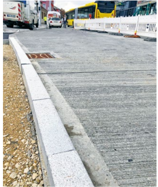
Bords adhésifs sur une surface en béton greaillée
