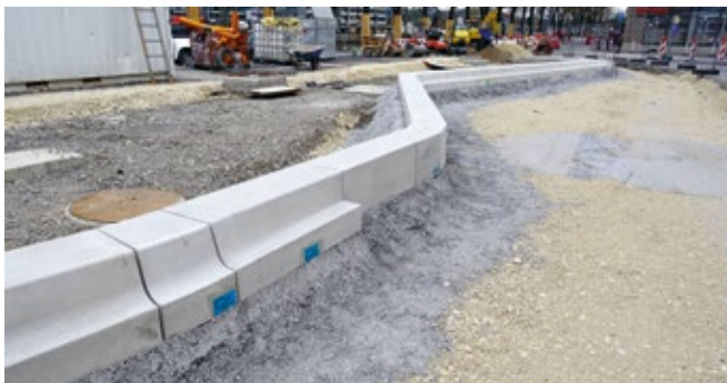
Version classique avec du « béton renforcé par une butée dorsale » (« bordures de type Kassel »)
