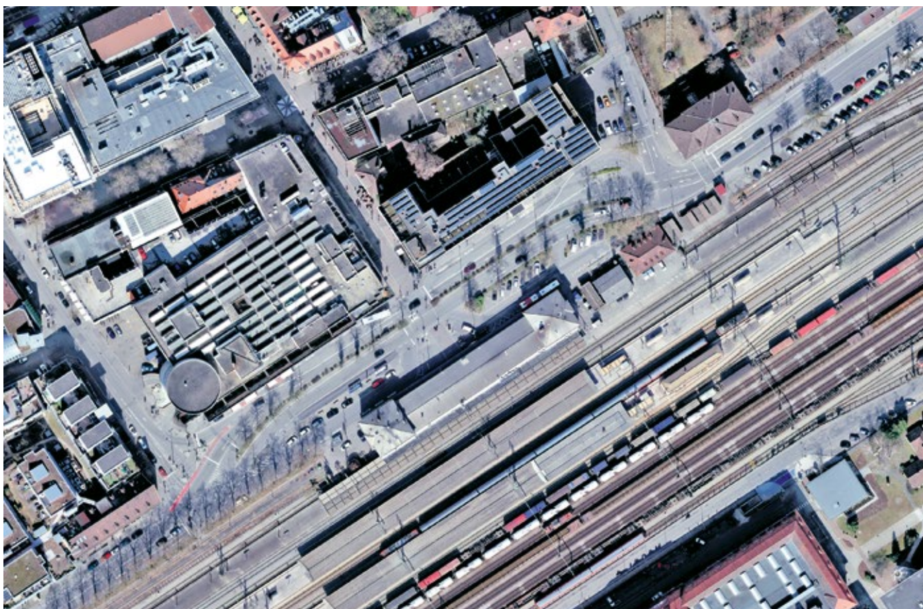
Gare routière centrale de Singen : vue aérienne avant le réaménagement
