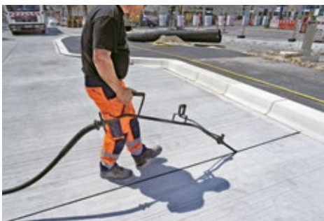
Remplissage des joints avec du bitume chaud de type N2
