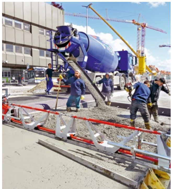
Mise en œuvre du béton avec toboggan et poutre vibrante
