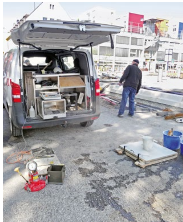
Contrôles du béton frais sur le chantier avec un véhicule laboratoire
