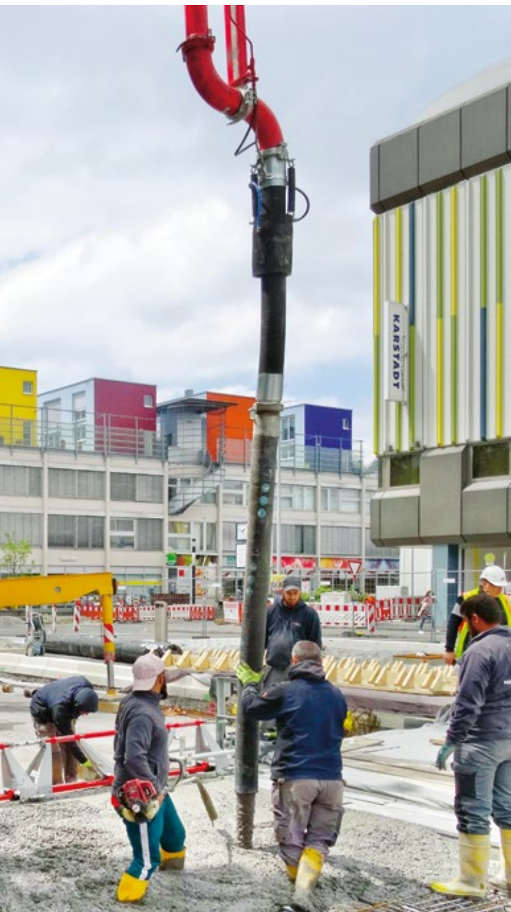
Mise en œuvre du béton avec toboggan et poutre vibrante
