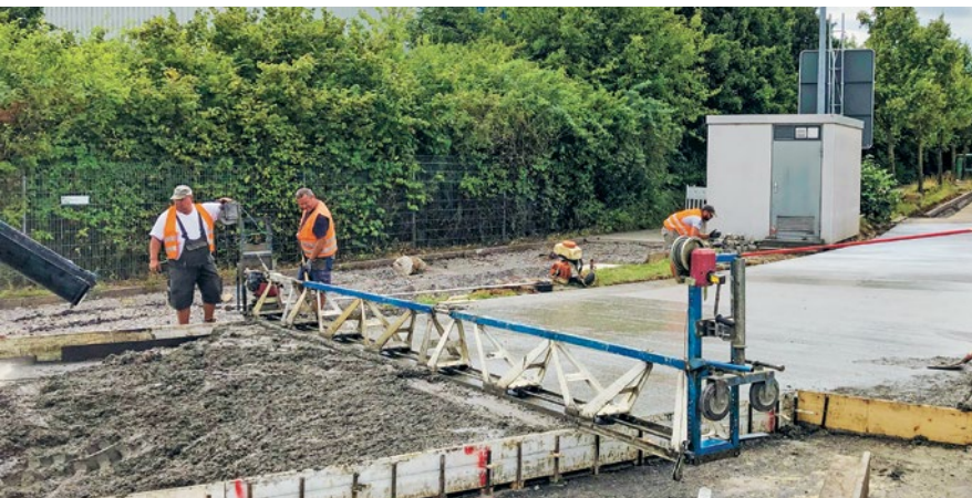
Mise en place de béton de la classe de consistance F3 avec une poutre vibrante
