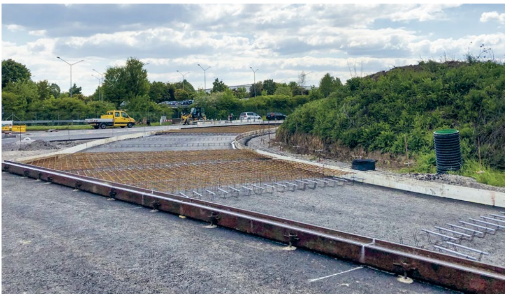
Positionnement des goujons dans des paniers supports, zone d'armatures géométriquement critique
