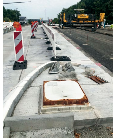
Collage des bords : intervalles de 3 à 5 mm entre les bordures
