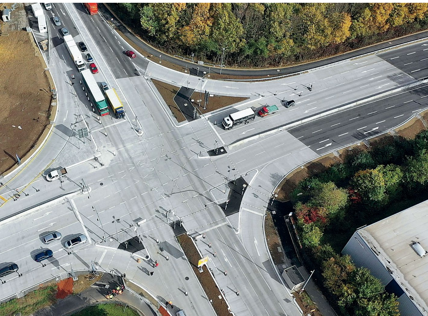
Vue aérienne du carrefour Daimler à la fin des travaux
