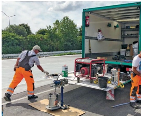
Scellement des joints : mise en place du produit de scellement à froid bi-composant à base de polysulfures
