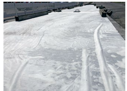
Cure supplémentaire avec un non-tissé servant à retenir l'eau
