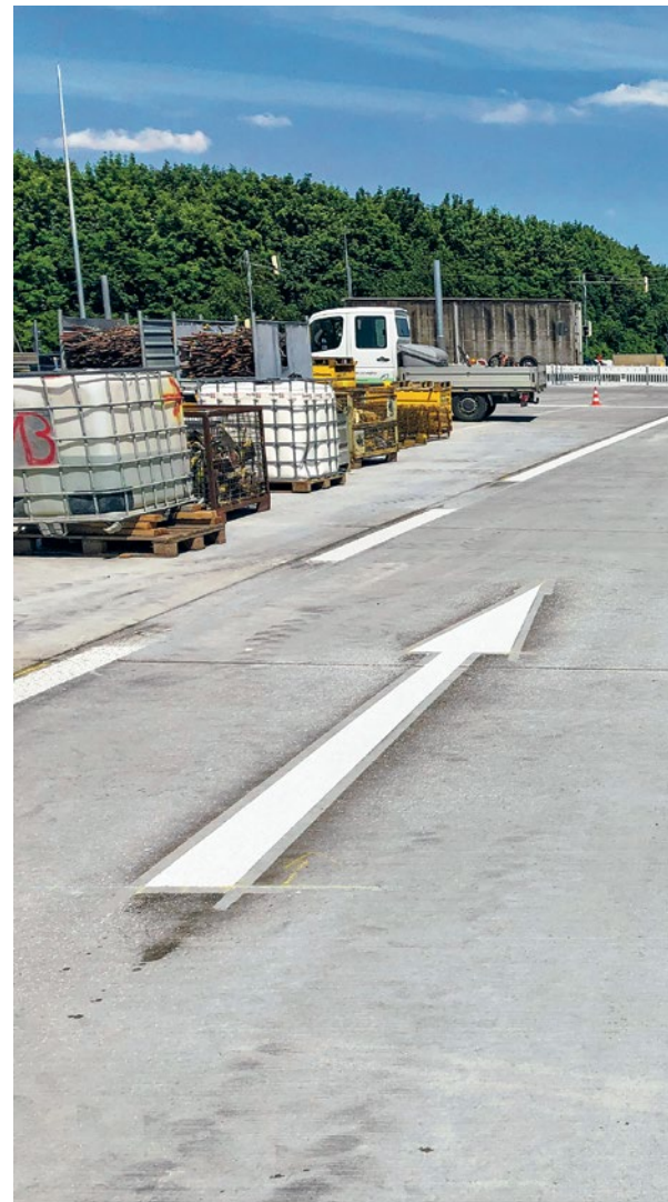
Travaux de marquage
