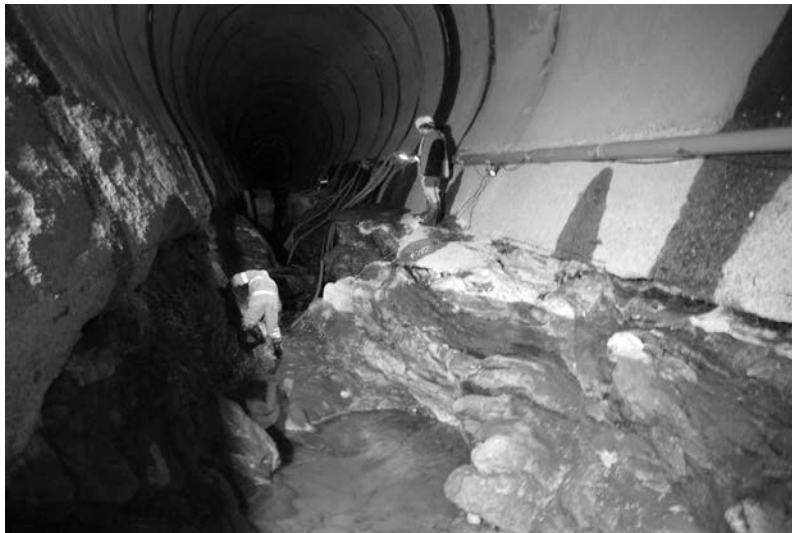
Abb. 1: Mehrere Meter in den felsigen Untergrund reichende Abrasion am SBT Palagnedra (TI, Schweiz).
