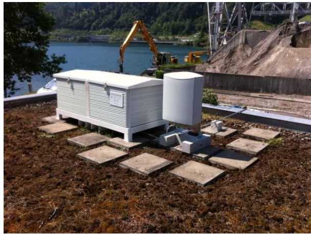
Abb. 1: Stevenson-Screen in Horw mit Messkasten für die unbewitterte Auslagerung von Betonprüfkörpern.
