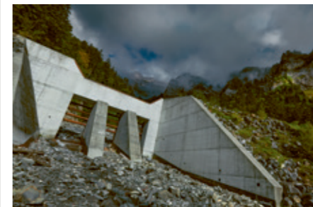
Hochwasserverbauung in Brienz Ouvrage de protection contre les crues à Brienz
