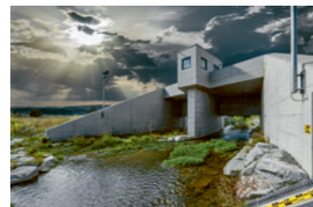
Rückhaltebecken in Wohlen Bassin de rétention à Wohlen
