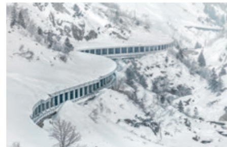
Galerie gegen Steinschlag und Lawinen in der Schöllenschlucht Galerie contre les chutes de pierres et les avalanches dans les gorges des Schöllenen
