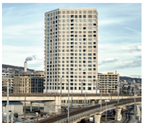
Tragende Fassadenelemente Direkt am Pfingstweidpark und am Gleisfeld liegend hat das 77 Meter hohe Zürcher Wohnhochhaus Zölly eine starke Präsenz. In der Tradition der schweren Vorfabrikation entwickelten die Architekten eine eigene Konstruktionsweise, die den Bauablauf massiv beschleunigte und ohne Gerüst auskam.
