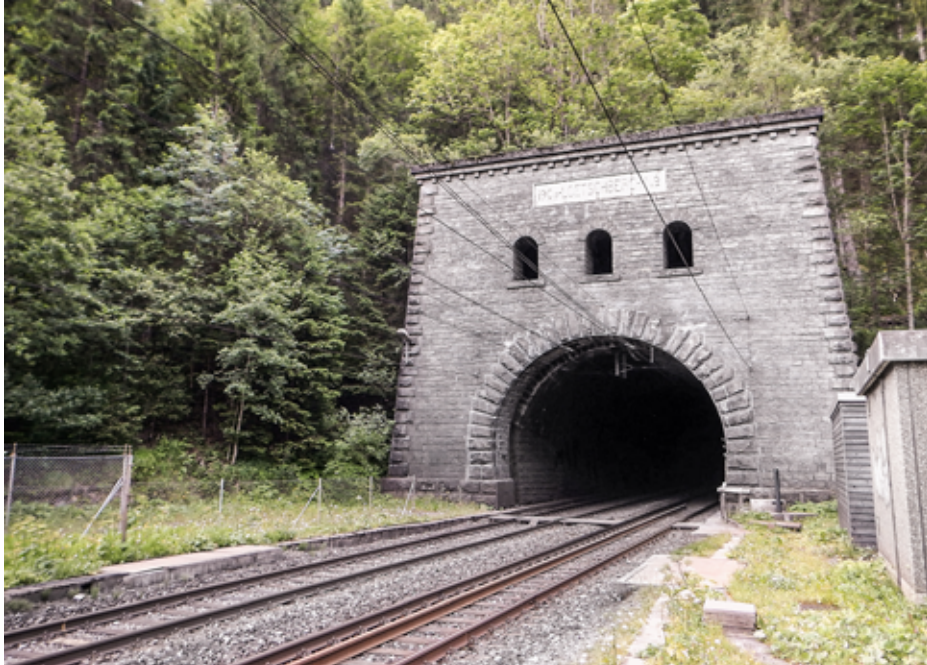
Das Nordportal des Lötschberg-Scheiteltunnels.
