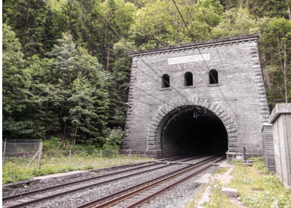
Das Nordportal des Lötschberg-Scheiteltunnels.
