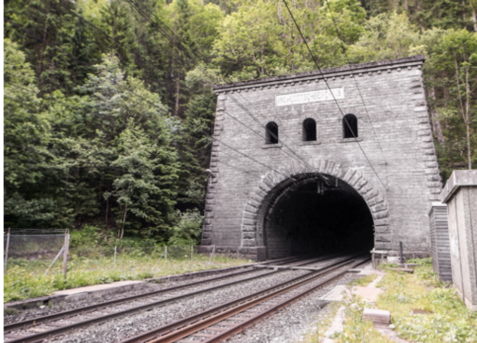
Das Nordportal des Lötschberg-Scheiteltunnels.
