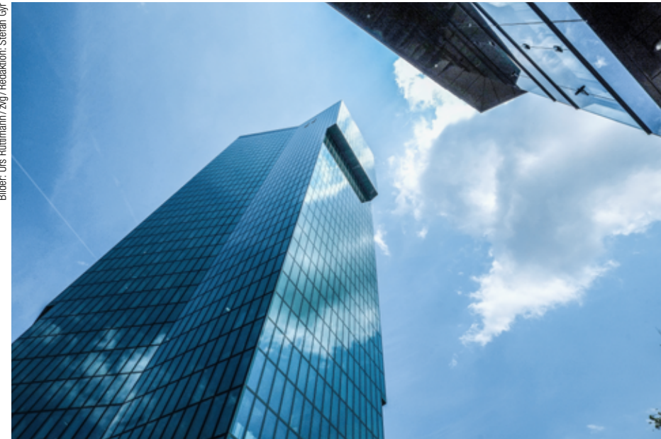
Prime Tower in Zürich: Solche Glaspaläste werden für ein angenehmes Klima viel Energie benötigen.
